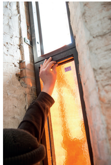
Afb. 5b Plaatsing van het nieuwe gevlamde glas (© Th. Blairon).
