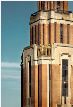
Afb. 1.1. Detail van de toren: parement van baksteen, hardsteen ( petit granit ), vergulde bronzen beelden, metalen schrijnwerk en gevlamd glas.
