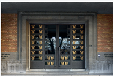
Afb. 1.2. De ere-ingang met metalen poort en decoratieve elementen in messing. Hardstenen ( petit granit ) poortomlijsting, plint en trap treden. Betonnen plafonds en profielen bedekt met similibeleistering.
