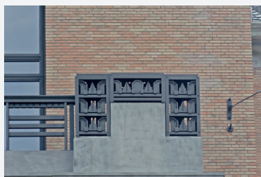
Afb. 1.5. Hardstenen ( petit granit ) borstwering met bewerkte decoratieve elementen in ijzer.
