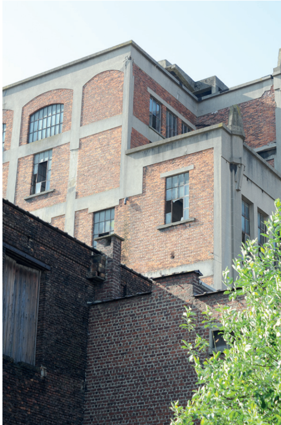
Afb. 7 Op de zijgevel van de toren werd het betonnen skelet met opvulmetselwerk zichtbaar gelaten (A. de Ville de Goyet, 2015 © GOB).
