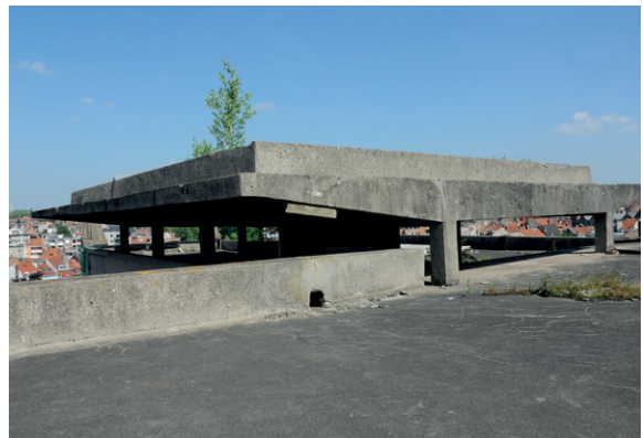
Afb. 10 Betonnen bakken om water op te vangen op het dak (A. de Ville de Goyet, 2015 © GOB).
