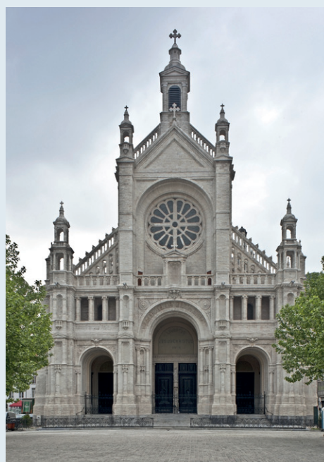
Afb. 1 Gevel van de Sint-Katelijnekerk na restauratie [A. de Ville de Goyet, 2013 © GOB].
