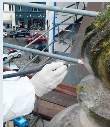
Afb. 3 Reiniging van de vazen in Savonnière kalksteen – test van microstraling (© ARTER, 2013).
