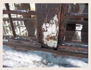
*Le Petit Renard et le Chêne/Het Vosken en Den Eycke.* Badly damaged window frame (© HHU, 2014).
