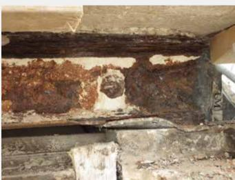
Le Petit Renard et Le Chêne/Het Vosken en Den Eycke. Corrosion and development of rust on a metal beam (© HHU, 2014).
