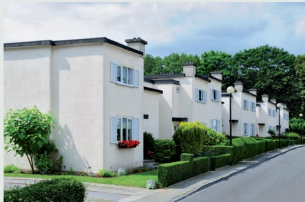
Tuinwijk Kapelleveld, Sint-Lambrechts-Woluwe. Arch. H. Hoste, stedenbouwkundige-landschapsarchitect L. Van der Swaelmen, 1922-1926. Actuele foto van de wijk ontworpen door H. Hoste (M. Vanhulst, 2012 © MBHG).
