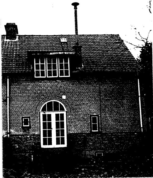
Façade latérale 2 - Zijgevel 2
