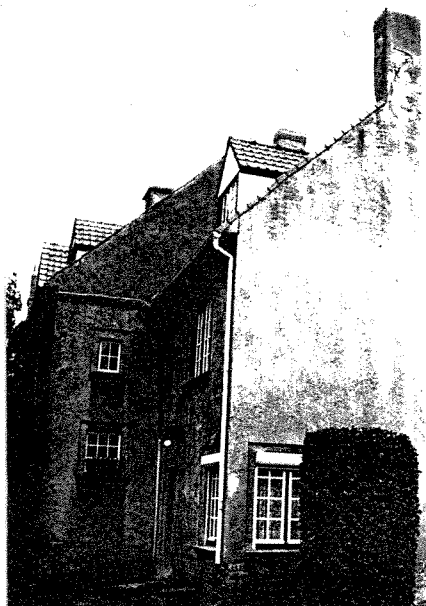
Façade latérale 1 - Zijgevel 1
