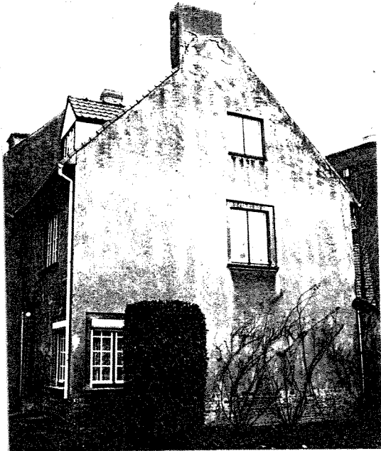
Façade latérale 1 - Zijgevel 1
