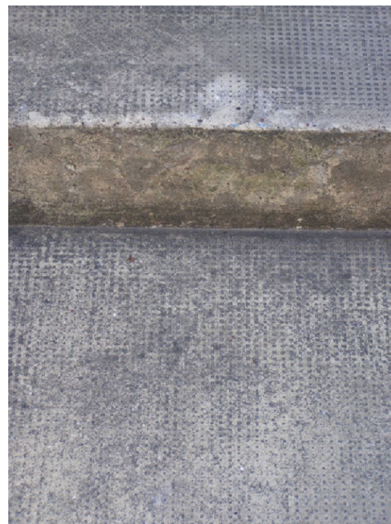
P7180048 - Wielewaalstraat nr. 24-26 rue du Loriot n°24-26
