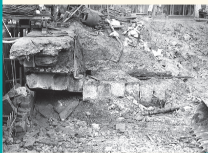
Vestiges du pont des Vanniers, 1968 Resten van de Mandenmakersbrug, 1968
