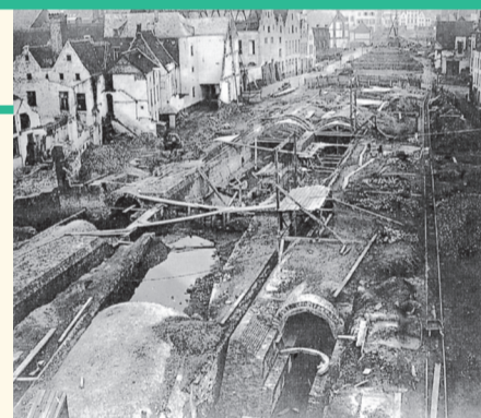
Voûtement de la Senne, 1870 Overwelving van de Zenne, 1870
