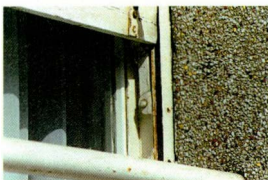
Mécanisme de volet
