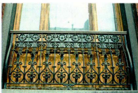
Garde-corps composé d'éléments galbés en fonte
