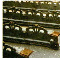
Relevé et détail des motifs décoratifs du faîtage après dépose
