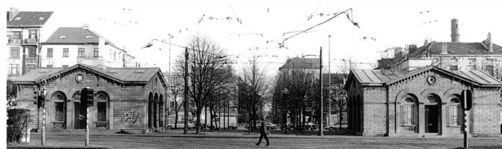
Vue actuelle de la porte de Ninove et des pavillons d'octroi.
