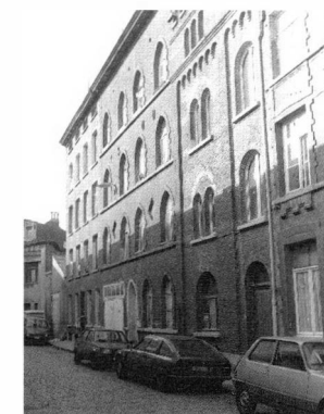
Quelques-unes des maisons de rapport de la rue Darimon. Les extensions de la Minoterie Farcy qui fermaient l'impasse ont été démolies.
