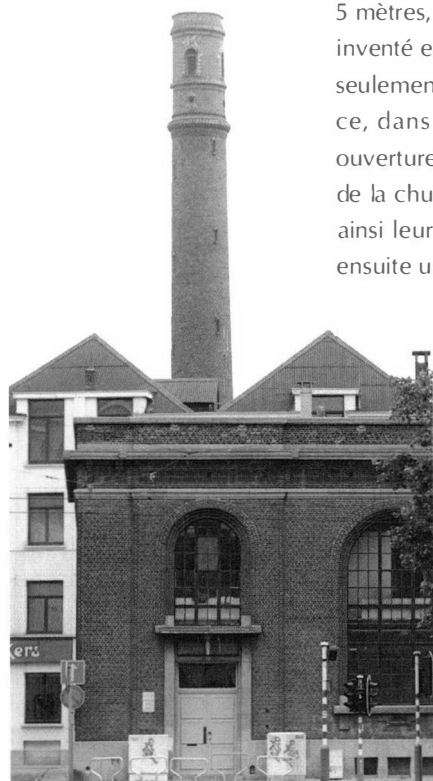
La tour à plomb, construite en 1898, domine le quartier des Fabriques. A l'avant plan, la sous-station électrique occupe l'emplacement de la Petite Ecluse de la Senne.
