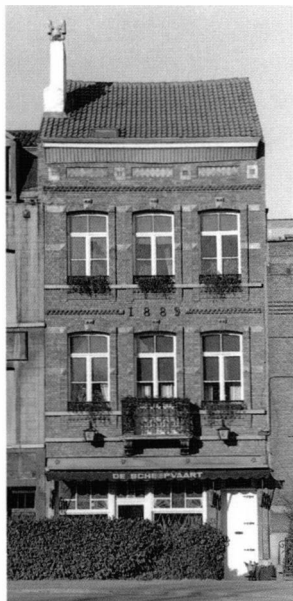
Le café «Scheepvaart» existe toujours, mais tourne le dos au canal. Depuis 1954, seules des automobiles circulent encore le long du quai de Willebroeck.
