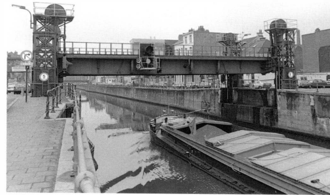
Le pont-levant dit « des Hospices » relie les rues de Manchester et de Liverpool.
