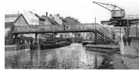
L'ancienne passerelle piétonne de la rue de Gosselies, construite par les patrons molenbeekois pour faciliter la circulation de leurs ouvriers entre les deux rives du canal. Cette passerelle métallique est aujourd'hui remplacée par un pont en béton.
