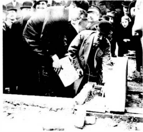
A l'occasion de l'inauguration du chantier, un parchemin historique est déposé sous la «première pierre». L'épouse du bourgmestre reçoit en souvenir une truelle dorée. Photographie de 1932.
