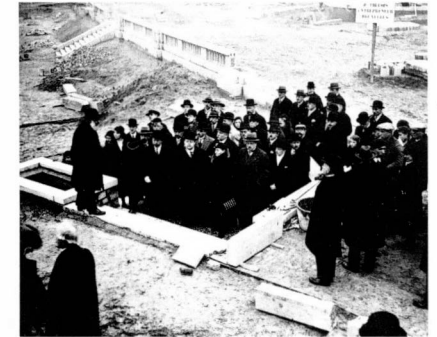
Cérémonie de la pose officielle de la première pierre du square le 23 janvier 1932. A ce moment, les travaux de terrassement sont terminés et les grandes lignes de composition du square apparaissent sous les traits de la maçonnerie en pierre bleue. Photographie de 1932.
