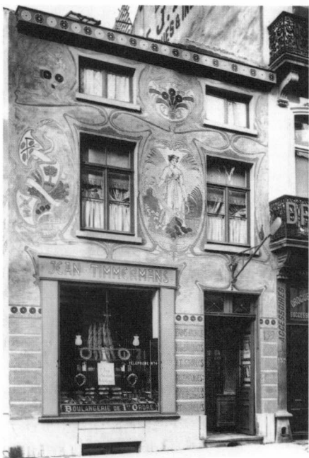
Façade de la boulangerie « Timmermans » (démolie) qui a remporté le concours de décorations commerciales organisé par la commune en 1896. On la doit aux talents de Paul Hankar (arch.) et Adolphe Crespin (sgraffites).
