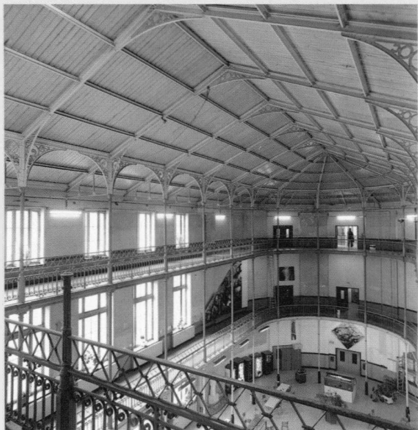
Derrière une façade fort discrète, l'ancien athénée cache cette structure métallique spectaculaire.
