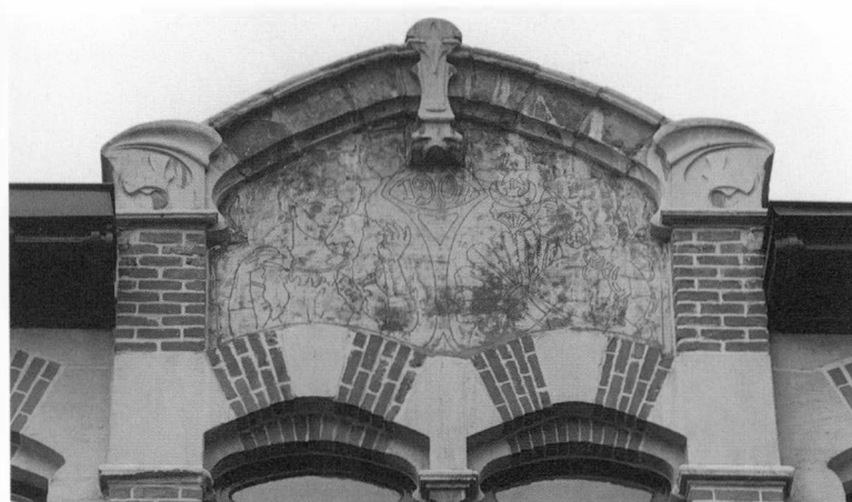
Sgraffite sous corniche du 18, rue Saint-Boniface.
