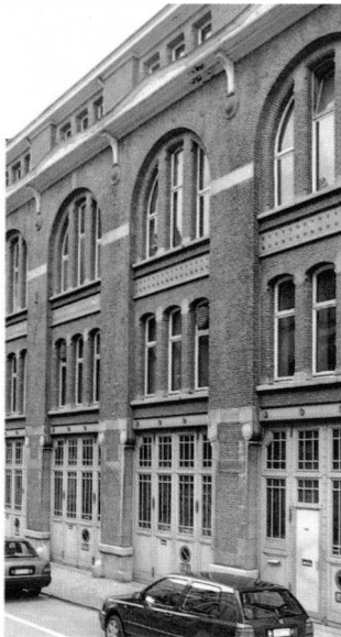
L'arsenal des pompiers déploie une très belle façade décorée de briques polychromes et de carreaux en céramique (24-26, rue du Viaduc).
