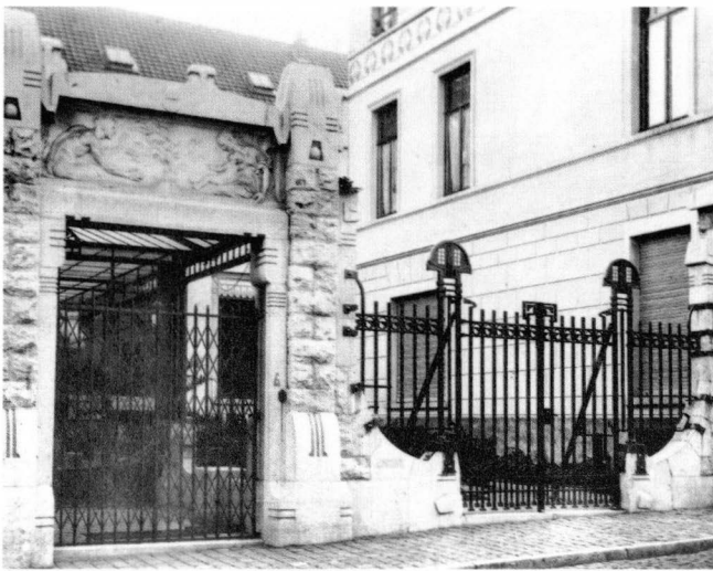
Photo de l'entrée des habitation et ateliers du charbonnier Taymans, extraite de Vers l'Art , 1908. Aménagement en style Art nouveau géométrique dû à l'architecte Paul Hamesse, (6-6A, rue des Champs Ellysées).
