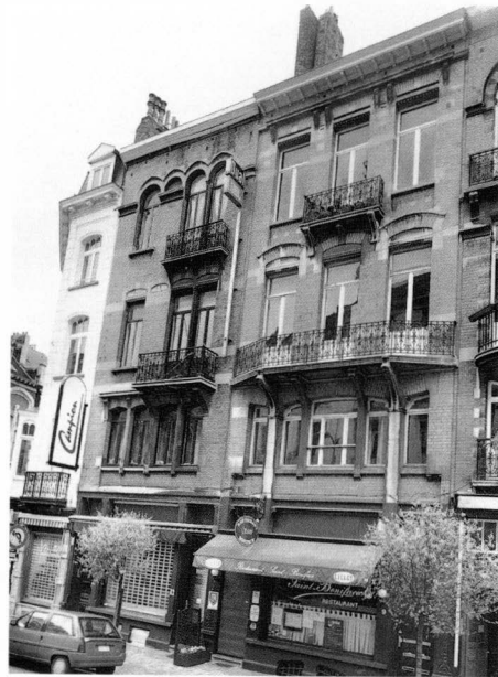
Ensemble de trois maisons réalisées par Henri Jacobs (rue Saint-Boniface, 7, 9 et 11).
