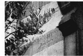
Signature de l'architecte Henri Van Massenhove sur la façade des n° 42 et 43 square Marie-Louise. Le souci de créer une œuvre originale, soignée jusque dans le moindre détail, s'exprime aussi par la griffe de son auteur.
