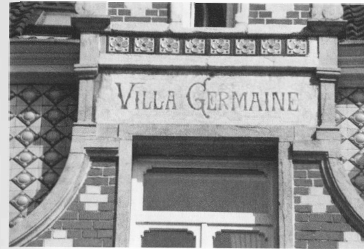
Jeux de briques de couleurs différentes, carreaux en faïence, mosaïque et pierre bleue s'allient pour faire vivre la façade du n° 24 avenue Palmerston. Cette maison, construite en 1897, était celle de Monsieur et Madame Houssa, les parents de Germaine.
