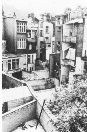
Vue de l'intérieur d'îlot entre les rues Philippe le Bon et Orféus et les squares Marie-Louise et Gutenberg, en 1973. Les façades arrières ressemblent à des meubles géants dont certains tiroirs seraient restés entrouverts.
