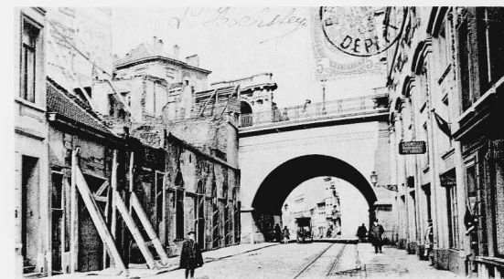
Le viaduc de la rue de la Loi enjambe le Maalbeek mais celui-ci, canalisé, n'est déjà plus visible. Seule la chaussée d'Etterbeek passe, telle une rivière de pavés, sous l'arche du pont.
