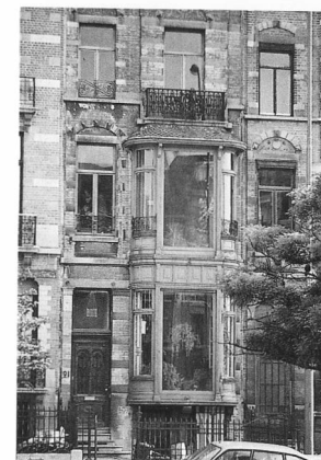
Le bow-window peut tantôt avoir été conçu dès l'origine, tantôt résulter d'une transformation ultérieure, comme ici, au n° 21 avenue Palmerston.
