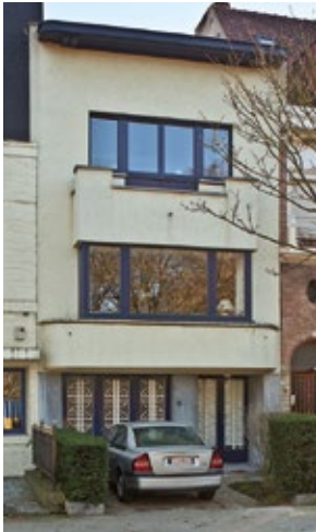
Maison particulière, avenue Jupiter 15. Arch. Henri Leborgne, 1936. (photo A. de Ville de Goyet © SPRB)
