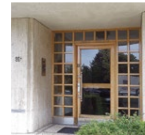
Entrée de l'immeuble à appartements Duden Horizon, avenue Jupiter 91A. Arch. Roger Dejeneffe et Joseph Thomas, 1952. (photo de l'auteur)
