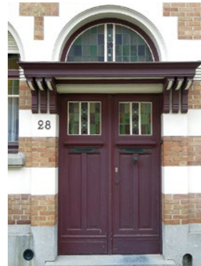
Détail de façade, rue de l'Escrime 28. Arch. François Van Meulecom, 1925. (photo de l'auteur)
