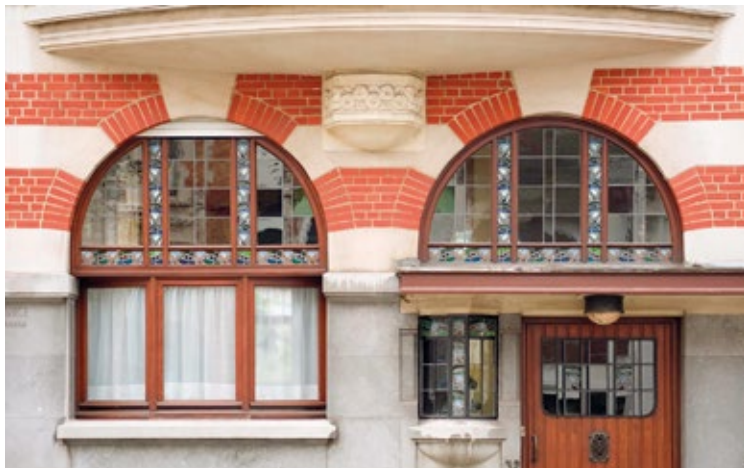
Détail de façade, rue de l'Escrime 32-34. Arch. Georges France, 1923. (photo A. de Ville de Goyet © SPRB)
