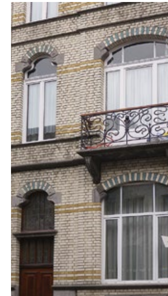
Maison d'habitation, avenue Saint-Augustin 30. Arch. Alphonse Boelens, 1903. (photo de l'auteur)
