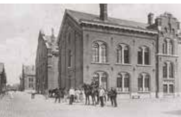
La caserne d'artillerie à Etterbeek autour de 1900 : entrée côté boulevard et intérieur côté chaussée de Wavre.
