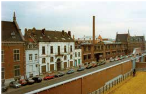
L'enfilade de la caserne du Train (Quartier-Maître) avant la démolition de la partie centrale dans les années 1990.
