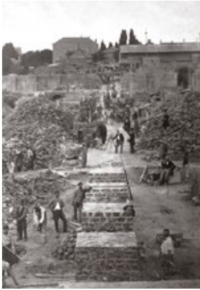
Construction des massifs de fondations et des structures portantes des voûtes des caves.
