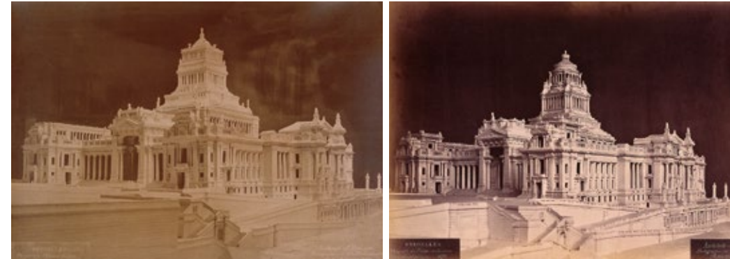
Photographie de la maquette du Palais de Justice. Le dôme de 1862 acquiert un caractère plus monumental grâce à une deuxième colonnade.
