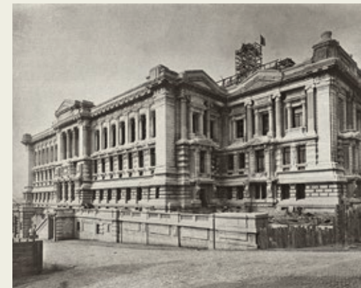
Echafaudages pour la construction du dôme.
