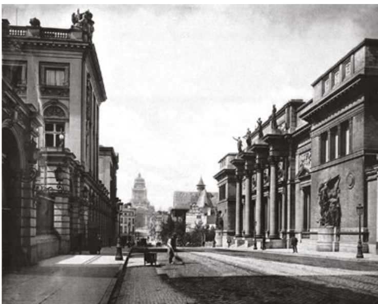
Vue de la rue de la Régence à partir de la place Royale, avant et après la construction du Palais de Justice: à droite, le Palais des Beaux-Arts, actuellement le musée d'Art ancien. Dans le fond, on distingue l'église Notre-Dame du Sablon avant sa restauration.
