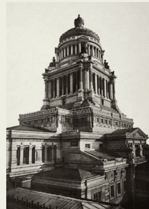
Le dôme, photographié à partir du toit du pavillon de droite de la façade avant. Quatre statues en bronze sont disposées aux quatre coins du tambour de plan carré formant le raccord avec la base du dôme: la Force et la Justice, la Clémence royale et la Loi. Les statues de 1882 ont été réalisées par les sculpteurs Th. Vinçotte, A. Desenfans, A. De Tombay et A. Dutrieux. Au pied de chacune des statues, on distingue deux griffons.
