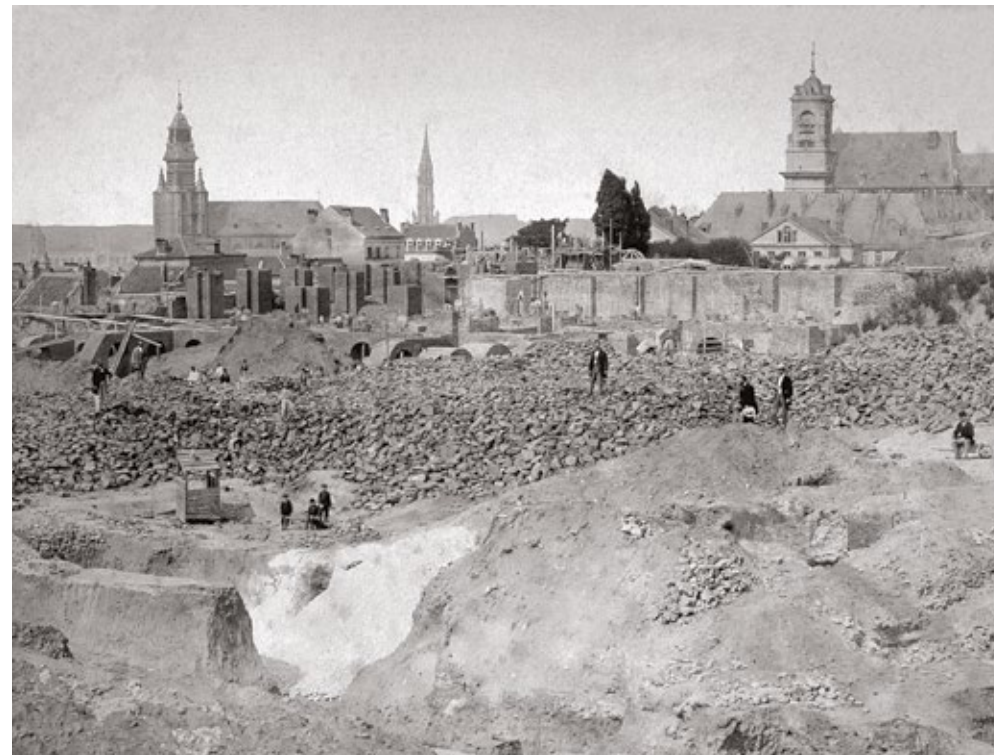
Chantier et travaux de terrassement du Palais de Justice. Au fond, de gauche à droite, l'église de la Chapelle, la tour de l'hôtel de ville, l'église des Minimes.
