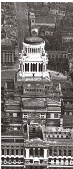
Vue aérienne de 1951 du Palais de Justice, gravement endommagé, avant la reconstruction du dôme.
