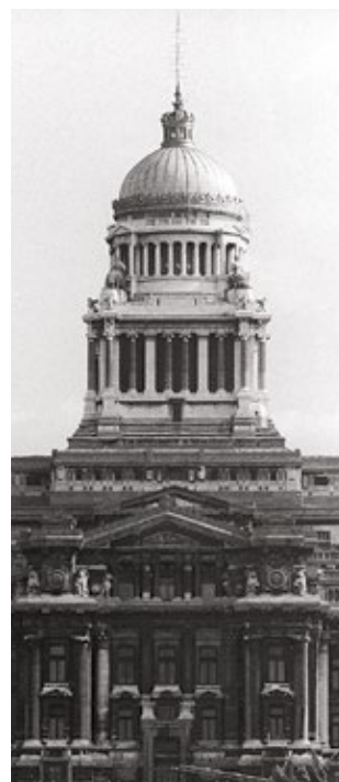
Pour accentuer la monumentalité de l'ensemble, le nouveau dôme a été rehaussé de 2,5 mètres par rapport à l'ancien.
