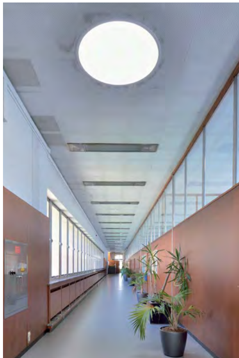
Couloir desservant les bureaux. (W. Kenis, 2023 © urban.brussels)
