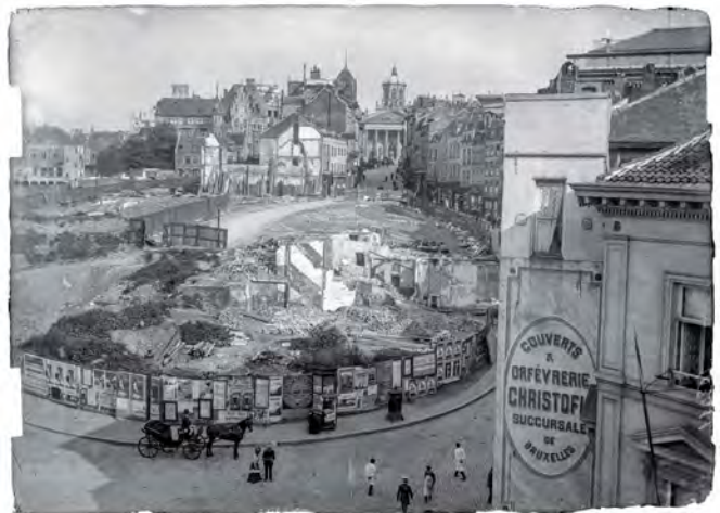
Le quartier Saint-Roch après sa démolition partielle, photo de 1905. Sur cette friche sera aménagé le square Vacherot, puis l'actuel Mont des Arts. (© KIK-IRPA, Bruxelles, a103011)
