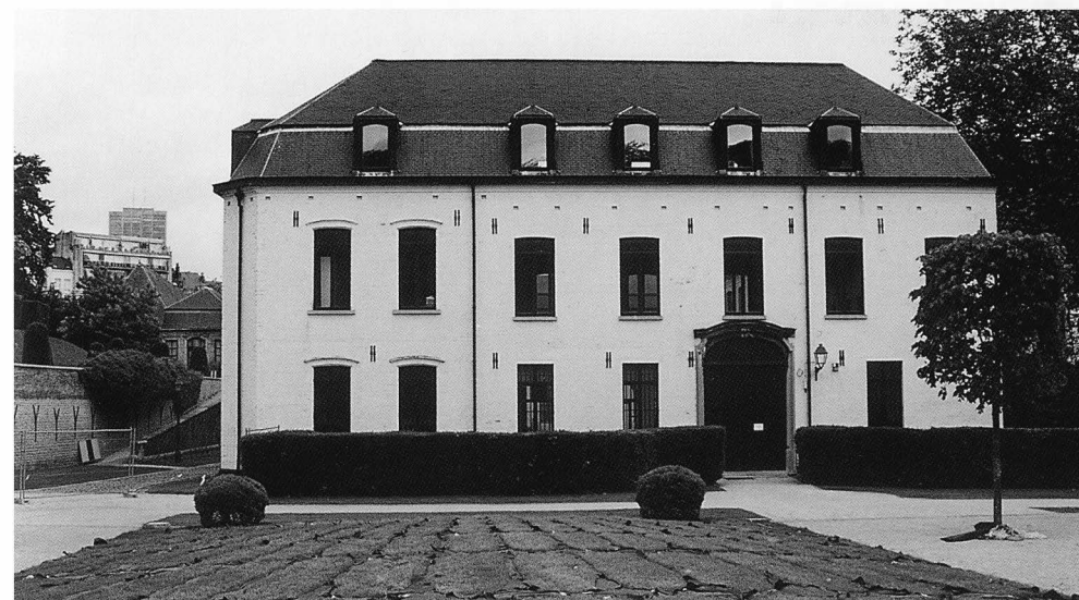
La façade latérale du bâtiment arrière du palais abbatial a été retravaillée en 1922.
