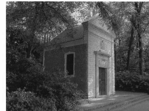
La chapelle Saint-Boniface après sa restauration.
