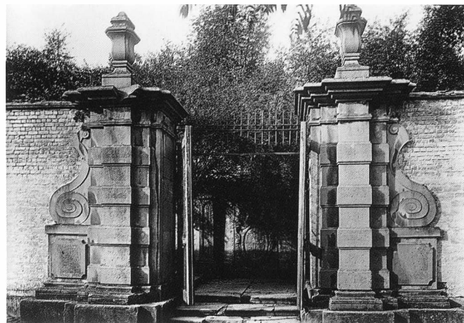
Portail de l'escalier monumental avant sa restauration en 1932.
