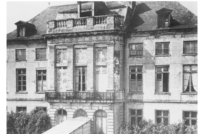
La façade côté sud dans un état de décrépitude avancé.
