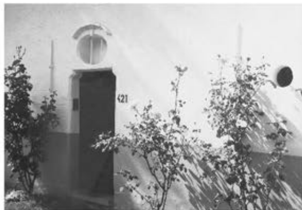
Un ultime vestige de l'octroi: une porte surmontée d'un œil-de-bœuf avenue de l'Exposition.
