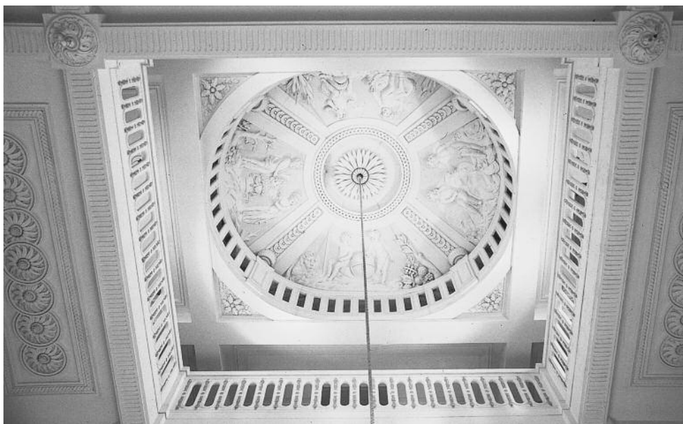
La coupole après la restauration de 1968. Les arcs de décharge ont disparu.
