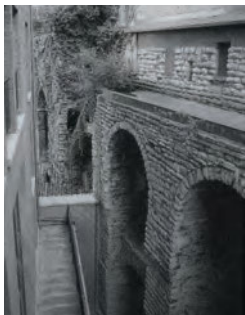
Cette vue actuelle de la courtine rue du Bois Sauvage, 17-21 montre clairement les arcs de soutènement du chemin de ronde et le parapet crénelé.
