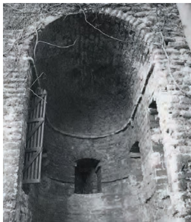
Vue de la voûte du rez-de-chaussée et détail des meurtrières de la tour du Pléban.
