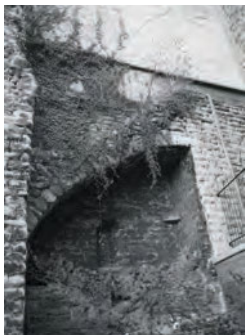
Vue actuelle de l'escalier sur arc rampant au départ de la tour du Pléban.
