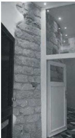
Cette tour, encore visible au n°42 de la rue des Chartreux, faisait partie du dispositif de défense du Driesmolenwiket.
