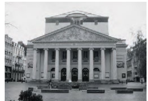
Depuis 1965, la place de la Monnaie, rendue piétonnière et agrémentée de fontaines, a été totalement modifiée. Seul le théâtre témoigne encore de la première disposition.
