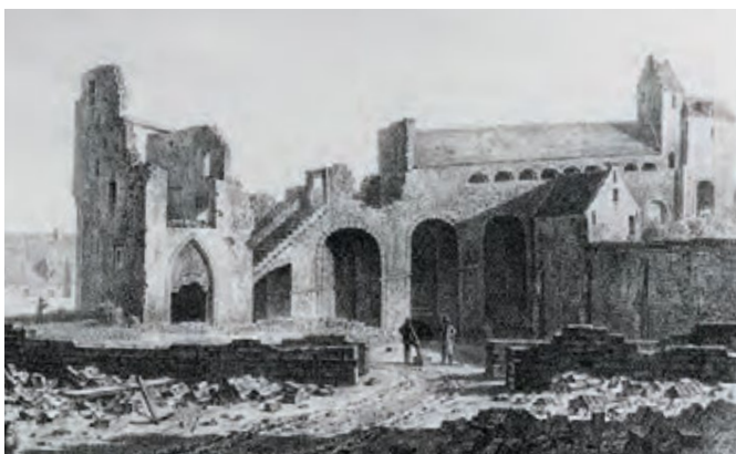
Vue de la tour dite de Berlaimont et du mur adjacent sur arcades lors de sa démolition en 1799. P. Vitzthumb.
