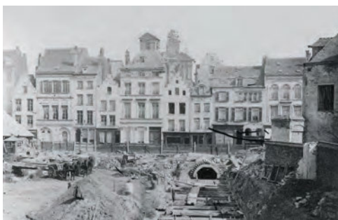
Pour la construction du voûtement de la Senne (bld. Anspach), il a fallu démolir des dizaines de maisons rue de l'Evêque. Ici, à l'arrière plan, au centre, on aperçoit une tour peu avant sa démolition. Cette tour a parfois été prise pour la porte de Malines.
