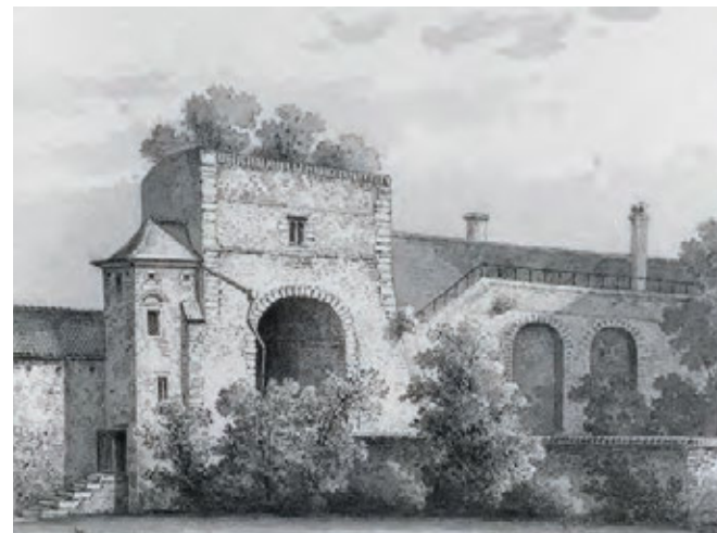
La tour du Pléban et sa tour d'escalier en brique datant du XVI e siècle.
