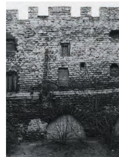
Le même tronçon de courtine vu de la cour de l'institut Sint-Joris.
