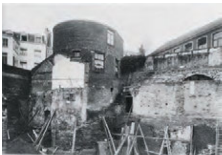
La tour de Berlaimont encore visible en 1909. Elle ne présentait plus que son soubassement d'origine en grès et deux étages modernes en briques. Le reste avait été démonté lors de la démolition du couvent en 1799.
