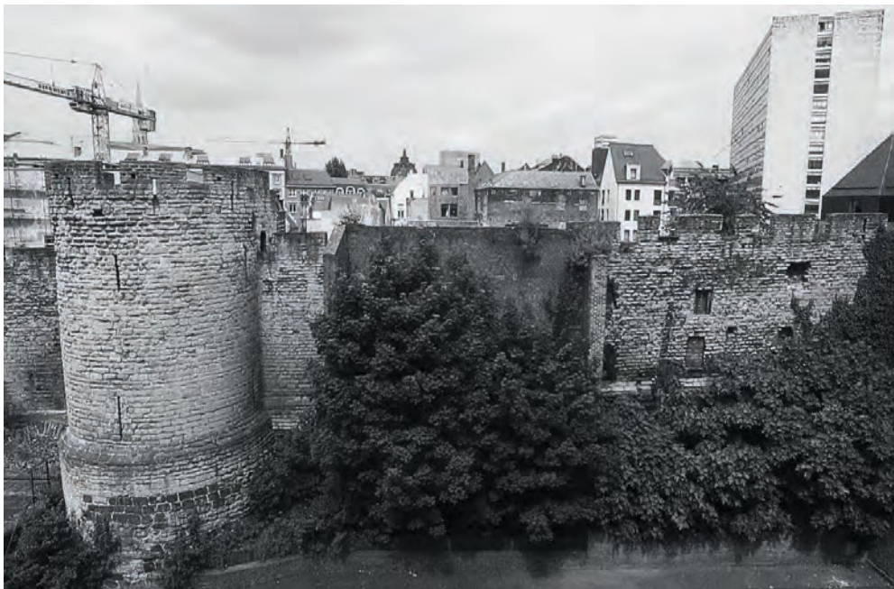
La tour de Villers vue extra muros et la courtine vers l'est.
