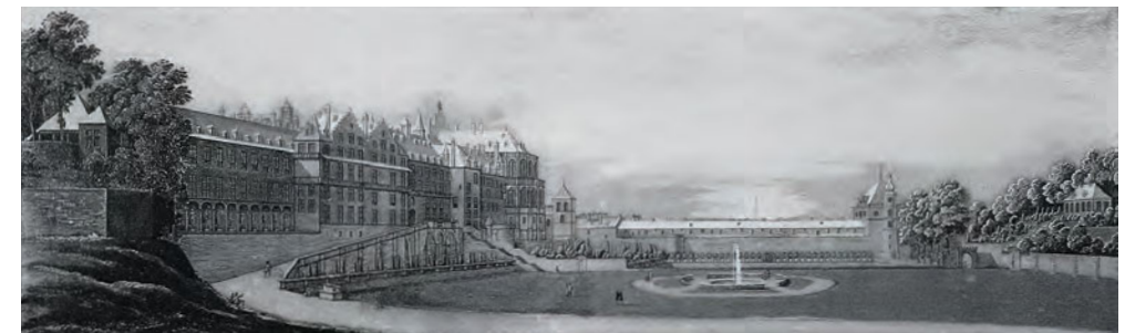
Le palais des ducs de Brabant après l'incendie de 1731 avec, à droite, la Domus Isabellae (aquarelle de F. Lorent).
