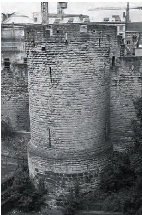
Vue latérale de la tour de Villers, extra muros, avec raccord aux fondations de la courtine.
