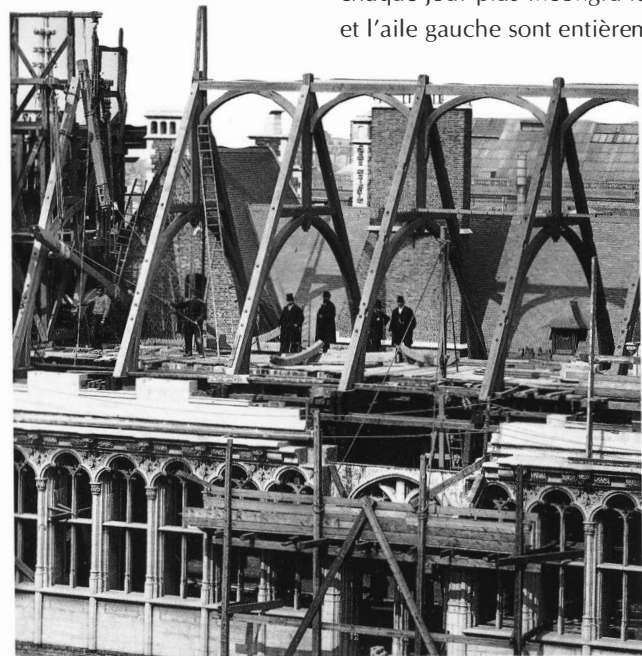
La Maison du Roi en cours de reconstruction.
