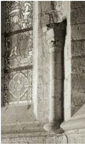
Colonnnette supportant autrefois la retombée des voûtes du chœur.
