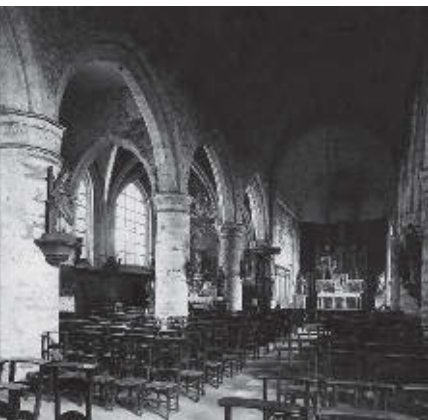
L'intérieur avant la restauration de 1925-1926, particulièrement sombre, avec sa voûte en berceau en plâtre de 1820.
