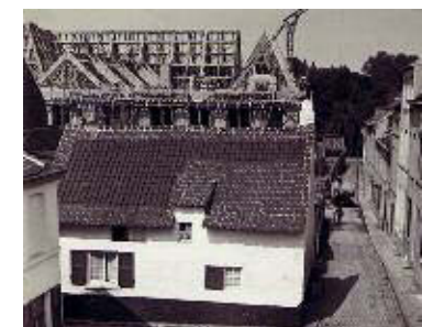
L'hôtel communal en construction (vers 1935), vu depuis la rue de Barcelone vers le square Omer Denis.
