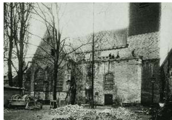
Le bas-côté nord en cours de «restauration» en 1925-1926.
