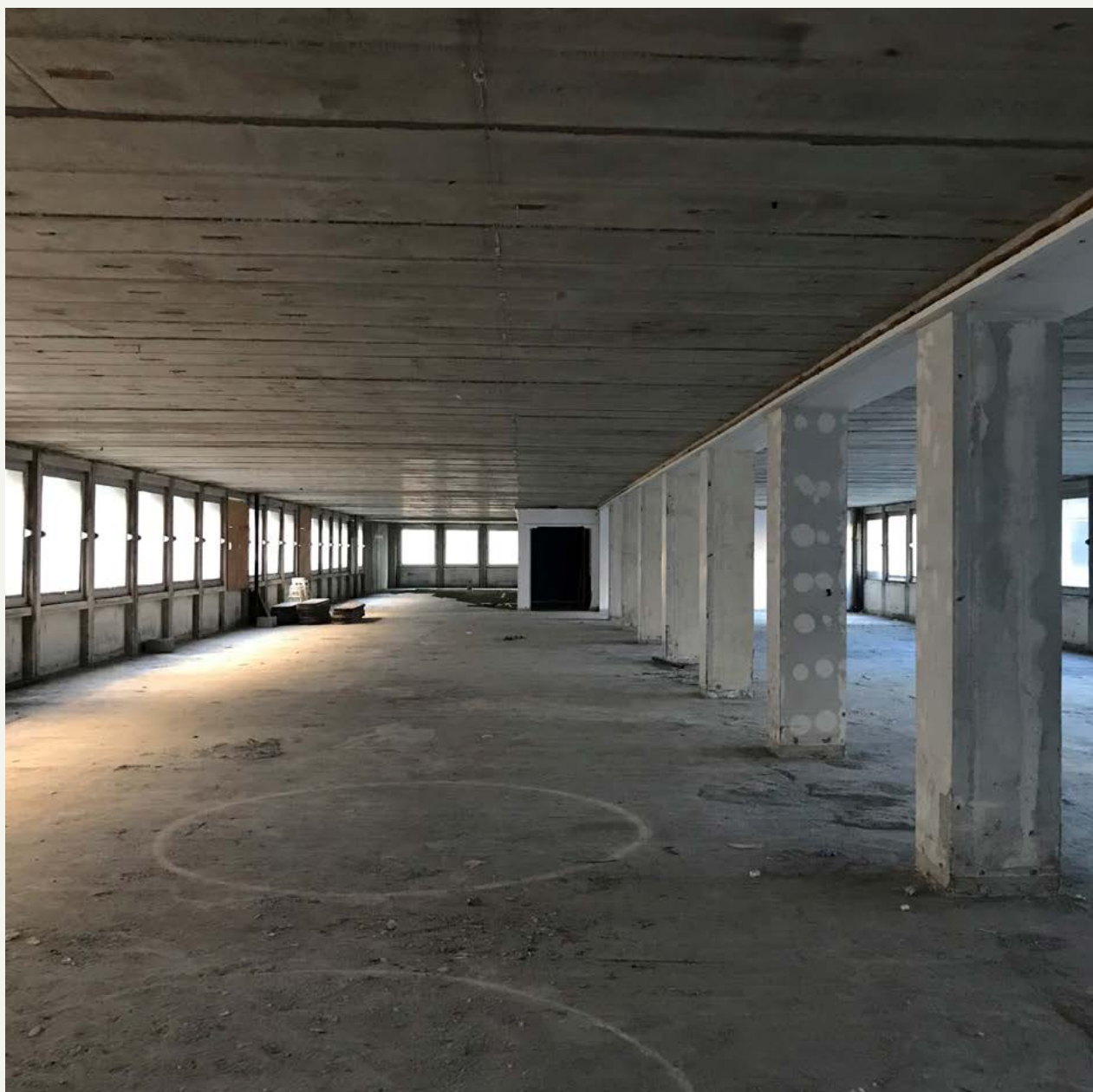
FIG. 6 Arlon 104, angle rue d'Arlon et rue Jacques de Lalaing, structure typique d'un étage de bureaux : grande profondeur et longueur du plateau, larges piliers structurels et hauteur sous plafond basse.
