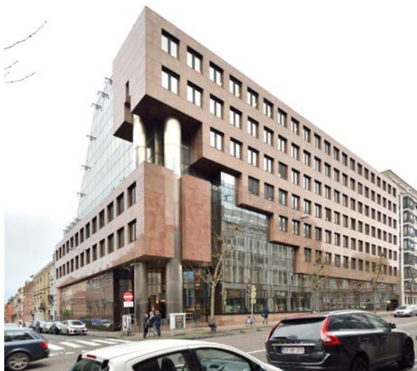
FIG. 1 Avenue Cortenbergh n° 150 à Bruxelles. L'immeuble dans son état d'origine, 2019 (W. Kenis © urban.brussels).
