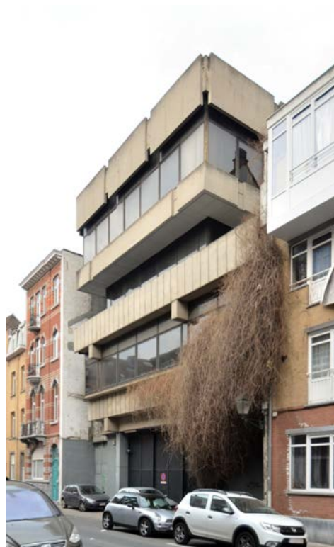
FIG. 1 Ancien siège S.A. Belge Cinzano rue de Belgrade n° 74 à Forest, dans son état d'origine en 2019 (W. Kenis © urban.brussels).
