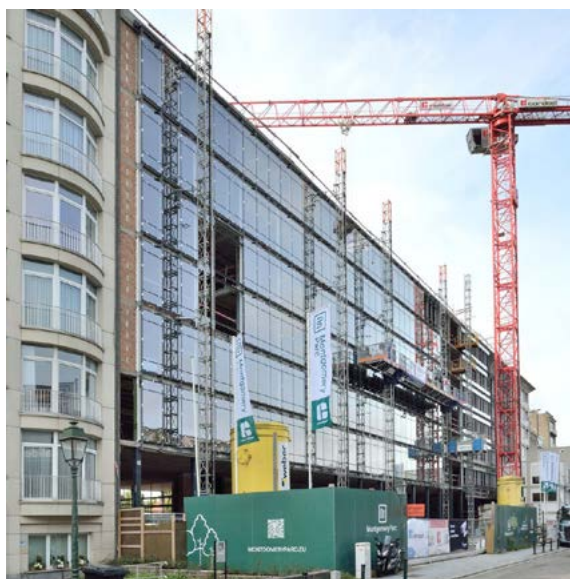
FIG. 3 Le chantier en 2024 (W. Kenis © urban.brussels).
