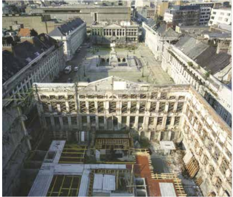
FIG. 13 Photo du chantier en 1993 (© Urban.Brussels, Centre de documentation, fonds A).
