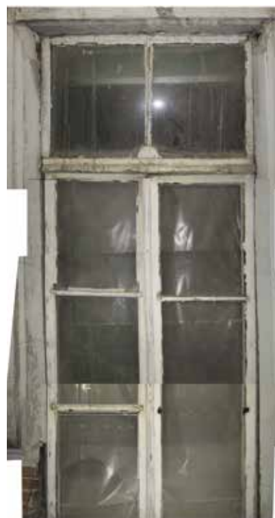
FIG. 17 Photomontage d'une fenêtre du XVIII e siècle du n°3 de la rue des Cèllets, photographiée depuis l'échafaudage, idem (© Fenikx bv, photo Ann Verdonck).
