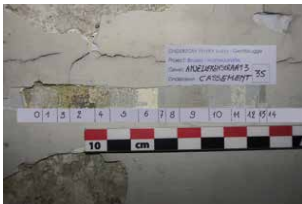
FIG. 16 Stratigraphie d'un caisson du n° 3 de la rue des Cèllets, idem (© Fenikx bv, photo Ann Verdonck).
