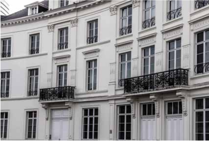
FIG. 1 La couleur contribue à la perception des bâtiments comme un ensemble par l'usage de tonalités chromatiques similaires. La place des Barricades à Bruxelles, de style néoclassique, aménagée aux environs de 1824 (A. De Ville de Goyet, 2021 © urban.brussels).
