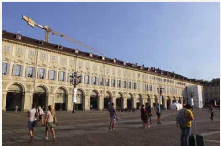
FIG. E1.3 La « Piazza San Carlo » à Turin. Les façades ont été restaurées selon la teinte jaune-ocre pâle ( giallo molera ) définie dans la charte chromatique reconstituée dans le cadre des travaux de Giovanni Brino (photo de l'auteur, 2016).
