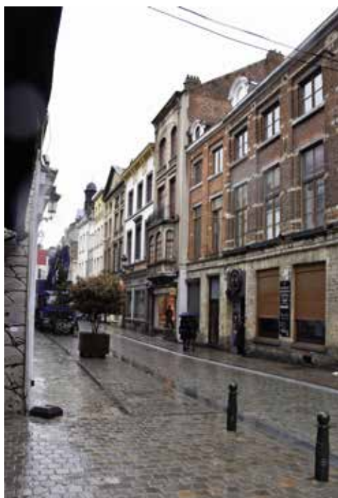
FIG. 3 La rue du Marché au Charbon, dans le périmètre 001 (2020 © LEMA-ULiège).
