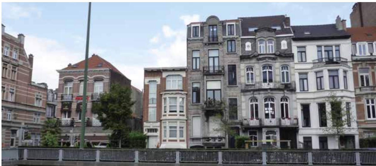
FIG. 2 La couleur peut fragmenter une scène urbaine par l'usage d'une palette polychrome. Le boulevard Brand Whitlock à Woluwe-Saint-Lambert dont le tracé remonte au début des années 1900 et qui présente une large variété de styles architecturaux. (2015 © Luan Nguyen).
