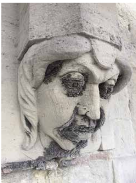
FIG. 5 Croûtes pathologiques sur visage sculpté et nettoyé, 2018 (© Ma 2 ).
