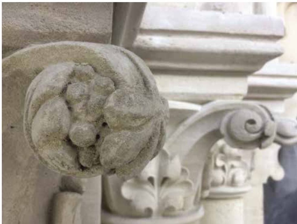
FIG. 10 Reconstitution au mortier de restauration d'une volute de chapiteau du portail du transept sud, dont le décor menaçait de disparaître, 2018 (© Ma 2 ).
