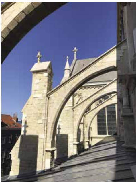
FIG. 8 Arcs-boutants renforcés et restaurés. Les toitures basses ont été renouvelées et les fleurons reconstitués, 2019 (© Ma 2 ).
