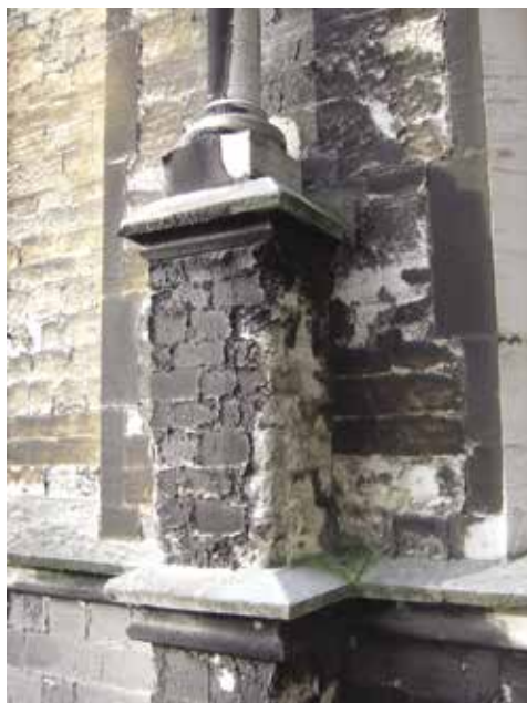
FIG. 3 Détail des croûtes pathologiques. A gauche, il est possible de distinguer la patine rouille clair caractéristique du parement en Steenockerzeel, 2008 (© Ma 2 ).
