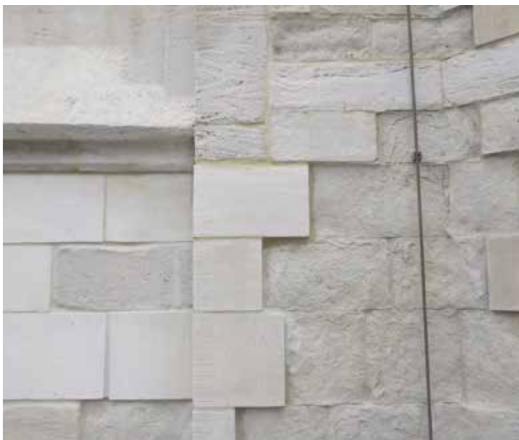
FIG. 9 Parement nettoyé et restauré. Les quelques pierres remplacées ont retrouvé leur finition d'origine ciselée, 2019 (© Ma 2 ).
