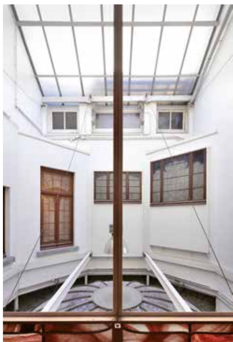
FIG. 14 Puits de lumière au-dessus de la coupole centrale en verre sous plomb, dans laquelle sont encore présentes deux petites fenêtres pivotantes d'origine en bois (photo Filip Dujardin, 2019).
