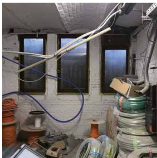
FIG. 8 Fenêtre d'origine côté rue, pourvue à l'origine d'une grille dans la partie supérieure (désormais absente) à travers laquelle l'air frais était amené le long d'un conduit en zinc attaché au plafond (n° 1 sur la fig. 6) (© B. Van der Wee Architects, 2019).
