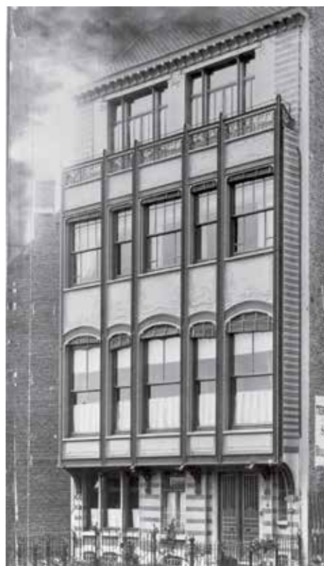
FIG. 2B Façade à rue de l'habitation d'origine avec sa structure en acier, 1897 (© KIK-IRPA, Bruxelles, cliché M102422).
