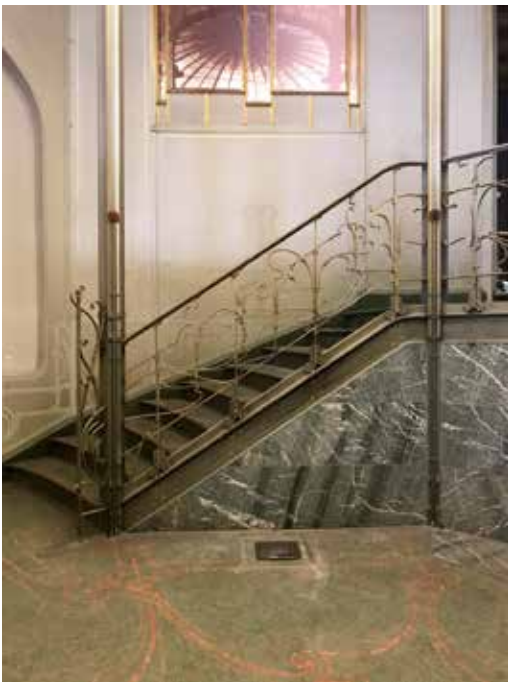
FIG. 11 Le jardin d'hiver : la grille de ventilation refermable par laquelle l'air frais est amené depuis la cave se situe dans le sol du jardin d'hiver octogonal, à l'endroit où l'escalier part vers le chemin de ronde. (n° 4 dans la FIG. 9) (© B. Van der Wee architects, 2020).
