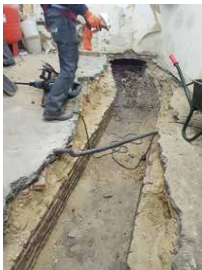
FIG. 7 Fenêtre d'origine côté jardin avec un soupirail faisant entrer l'air frais via un conduit souterrain en maçonnerie, qui a été redécouvert et restauré durant le chantier en 2019 (n° 4 sur la fig. 6) (© B. Van der Wee Architects, 2019).
