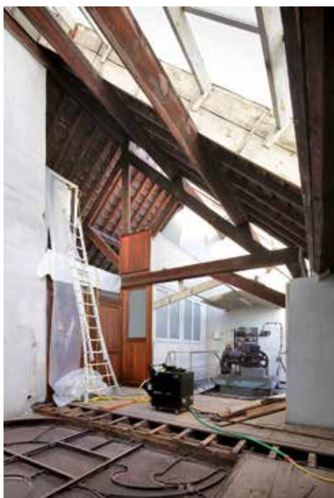
FIG. 15 Dans les combles du grand toit, on distingue dans le plan du toit, côté nord, les traces d'une verrière d'origine (obturée par la suite). Sur le sol des combles, on aperçoit les deux verrières qui faisaient entrer la lumière naturelle au-dessus de l'escalier privé et de l'escalier de service (photo Filip Dujardin, 2019).
