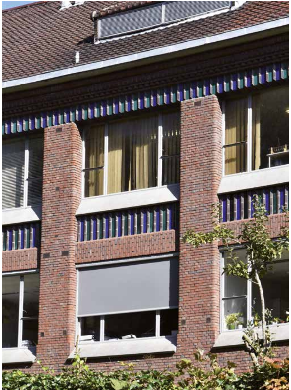
FIG. 8 Institut de recherches médicales Fondation Reine Élisabeth, avenue Jean Joseph Crocq 3 à Laeken (1927- 1930), arch. Henry Lacoste. On aperçoit les orifices de ventilation dans les murs de façade. Les petites grilles débouchent dans le bas des pièces et les grandes à proximité des plafonds (© ARCHistory / APEB, 2018).
