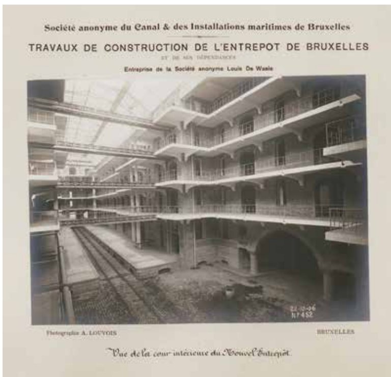
Fig. 4 Intérieur de l'Entrepôt royal à Tour et Taxis montrant les fins planchers en encorbellement (AVB, CI, M-80, photo de A. Louvois).
