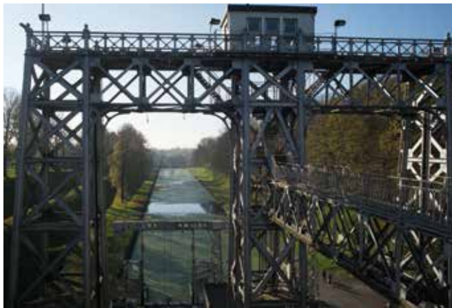
Dominique BAUDUIN Écluse/Ascenseur n°2 du Canal du Centre, Houdeng-Goegnies
