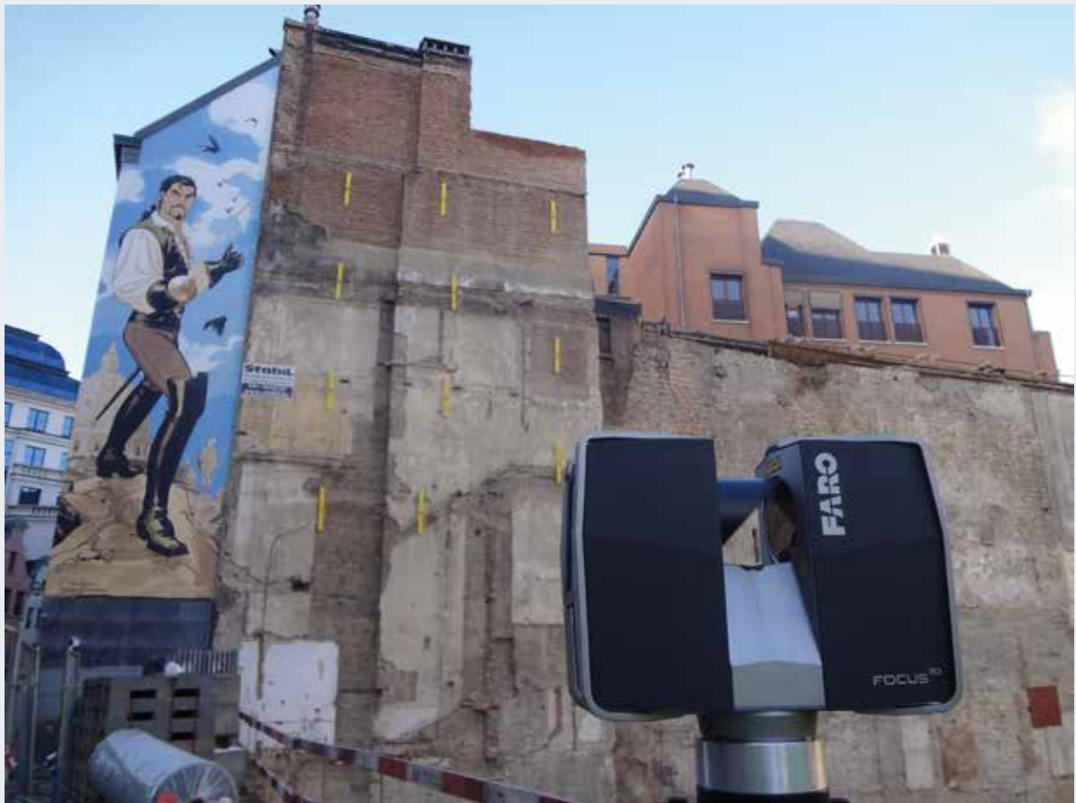
Scan 3D lors de la restauration d'un tronçon de l'enceinte urbaine datant du XIII e siècle, situé le long de la rue du Treurenberg, Bruxelles (C. Devillers, 2014 © BUP/BSE).
