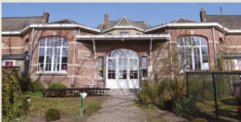
Vue actuelle de la crèche (photo de l'auteur).
