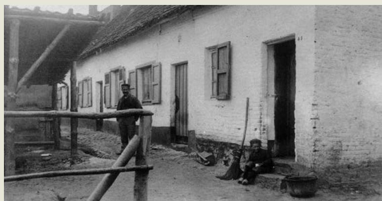
Cette rangée de maisons construite «en impasse», entre 1768 et 1812, du côté impair du Heiligenborre a été démolie à la fin du XX e siècle. À noter, le balai «boitsfortois» avec ses anneaux de noisetier (Watermael-Boitsfort, fonds Espace Mémoire).
