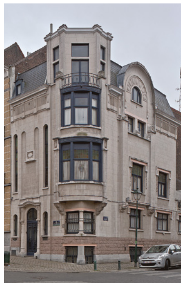
Fig. 5 Habitation et bureau de Paul Hamesse, avenue Jef Lambeaux 25, 1909-1910, Saint-Gilles (A. de Ville de Goyet, 2017 © SPRB)
