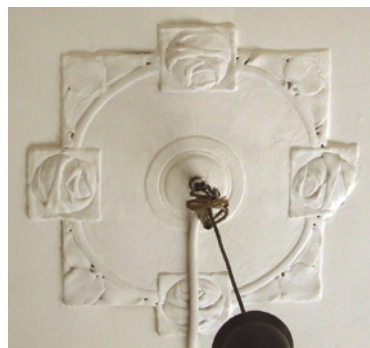
Fig. 7 Moultures du plafond, rue du Lombard 5-7, 1908-1909 (photo de l'auteur, 2014).
