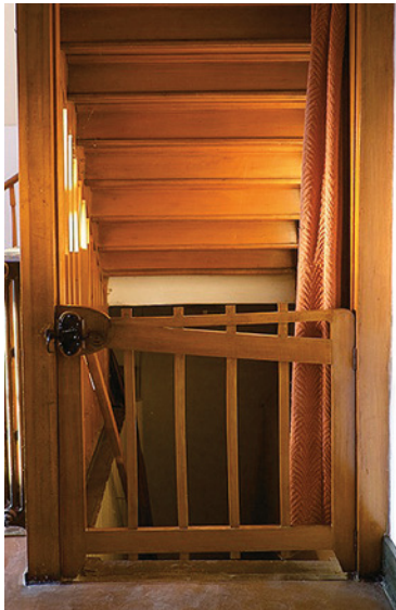
Fig. 2 Grille en bois protégeant l'accès de l'escalier de la cave (2016 © P. Schmückle von Minckwitz).
