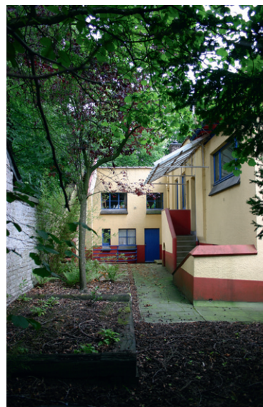
Fig. 11 Vue de la cour nord et de la façade ouest de l'extension (photo de l'auteur, 2013).
