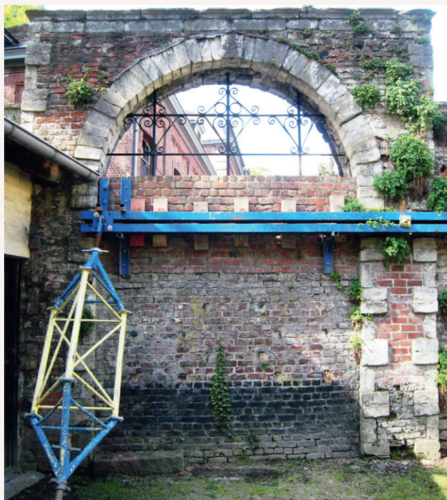
Fig. 1 La porte condamnée vue depuis l'est (photo de l'auteur, MRAH, 2014 © SPRB).
