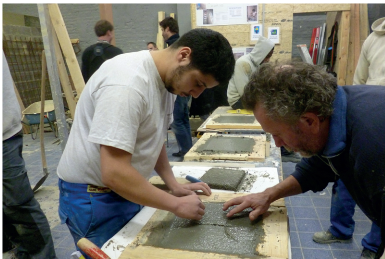
Fig. 5 Réalisation d'une dalle en granito, Institut Saint-Joseph, Etterbeek (2014 © CP).
