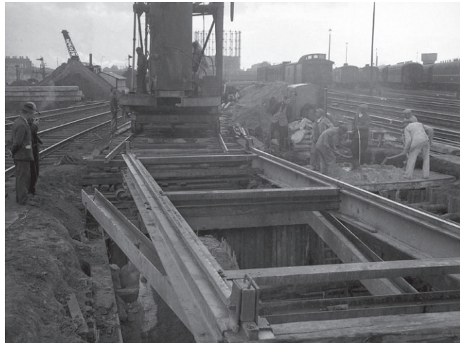
Fig. 8 Construction de la jonction Nord-Midi. Les expropriations et les travaux majeurs sur la jonction Nord-Midi ont entraîné chez les Bruxellois, longtemps après son ouverture en 1952, une crainte de nouveaux tunnels souterrains, des travaux de terrassement et de la rénovation urbaine en général (photo SNCB).
