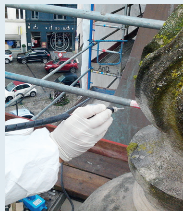
Fig. 3 Nettoyage des vases en pierre blanche de Savonnière – test de microsablage [© ARTER, 2013].
