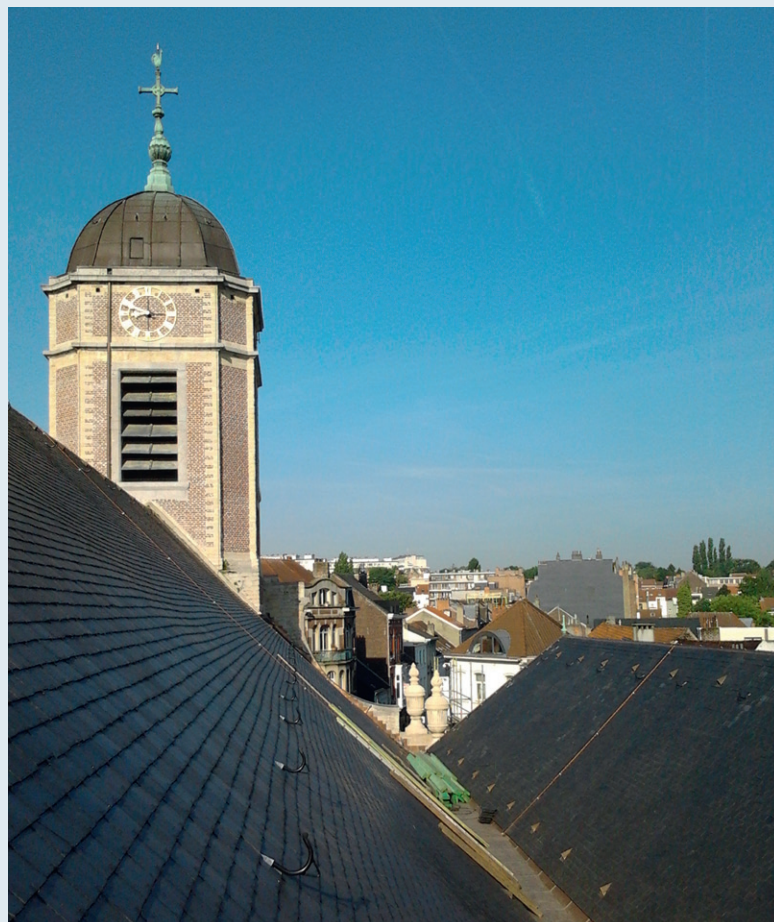
Fig. 6 Toitures restaurées de l'église et de la quatrième nef (© ARTER, 2014).
