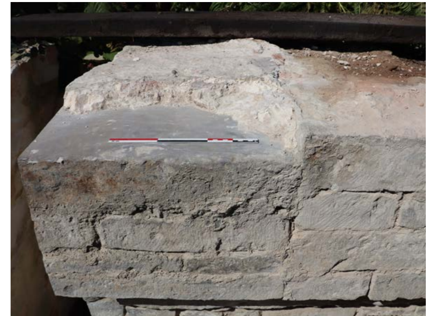
III. 91 : Mortier de chaux lié à la condamnation définitive de l'escalier de déchargement déjà réhaussé (© urban.brussels).
