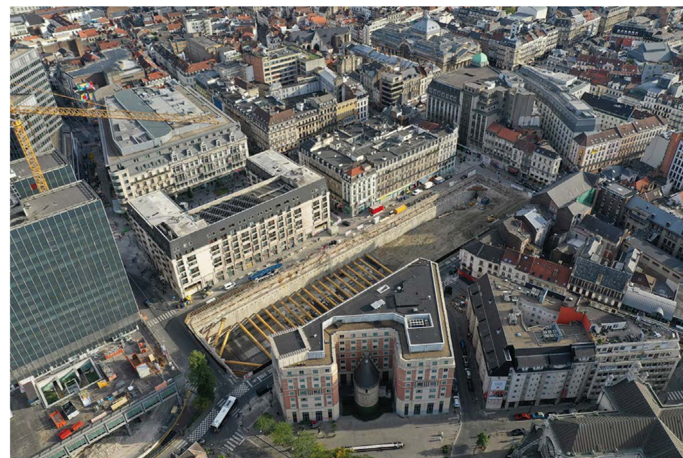
III. 5 : La parcelle en cours de construction après le départ de l'équipe archéologique (© AG Real Estate).
