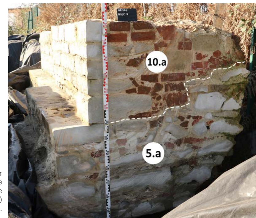
III. 84 : Section de maçonnerie sur laquelle on peut observer l'arrachage des anciennes marches et la pose d'un nouveau parement (10.a) (© urban.brussels).
