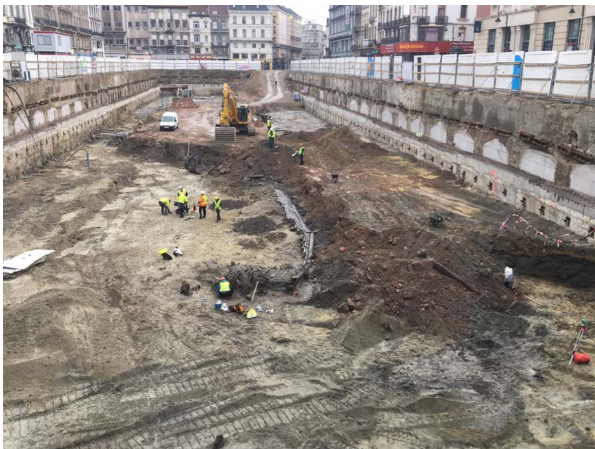
III. 4 : La cale en cours de dégagement, 2019 (© urban.brussels).
