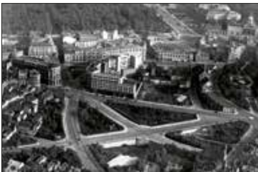
© Régie des Bâtiments
