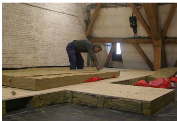
Pendant les travaux – novembre 2011
