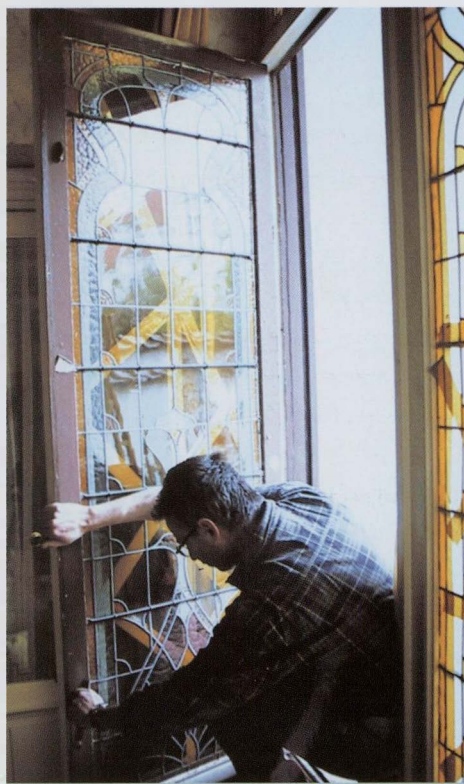
Plaatsing, Albaniëstraat 91, Sint-Gillis.
