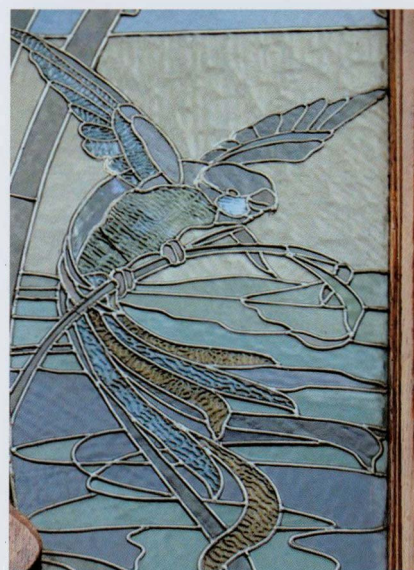
Soms, om een element op zijn plaats te houden of een barst te maskeren, is het nodig een loodband aan te brengen. Moricharplein 41, Sint-Gillis.
