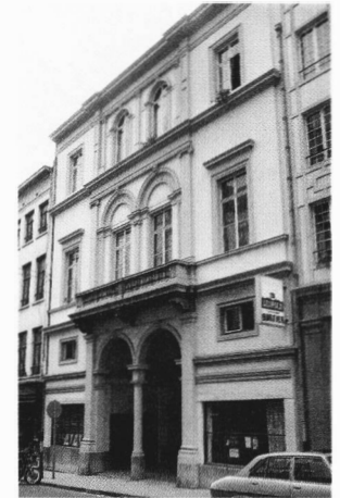
Sint-Jansstraat. Door architect Cluysenaar ontworpen ingang naar de Magdalenamarkt en de Bortiergalerij.
