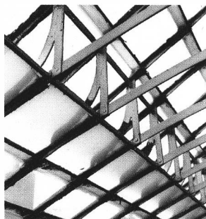
Aanzet van de T-ijzers die het glazen dak stutten.
