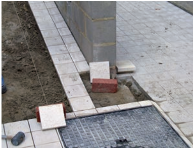
Fig. 19 Traditionele methode om tegels te plaatsen.
