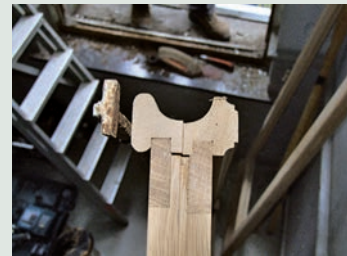
Vervanging van een raamvleugel in de achtergevel. Detail van de hollijst, van bovenaf gezien.
