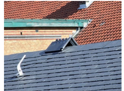
Fig. 16 Proefmontage van de makelaar in geglaazuurd aardewerk op de leistenen dakbedekking.
