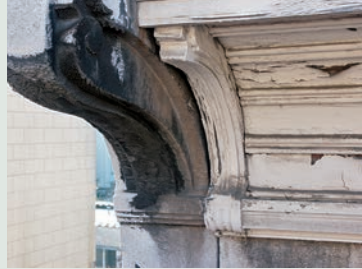
Korstvorming op de Euvillesteen ten gevolge van atmosferische invloeden
