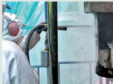
Lokale reiniging met hydropneumatisch zandstralen als aanvulling op een reiniging met stoom.
