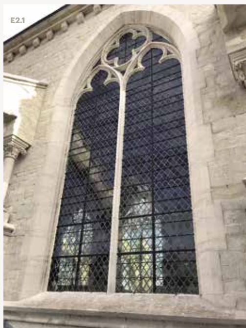
AFB. E2.1 Glas-in-loodraam met ‘kathedraalglas’ na de restauratie. Door de transparantie zien we de luchtbogen van de tegenoverliggende gevel, 2019. (© Ma 2 )
