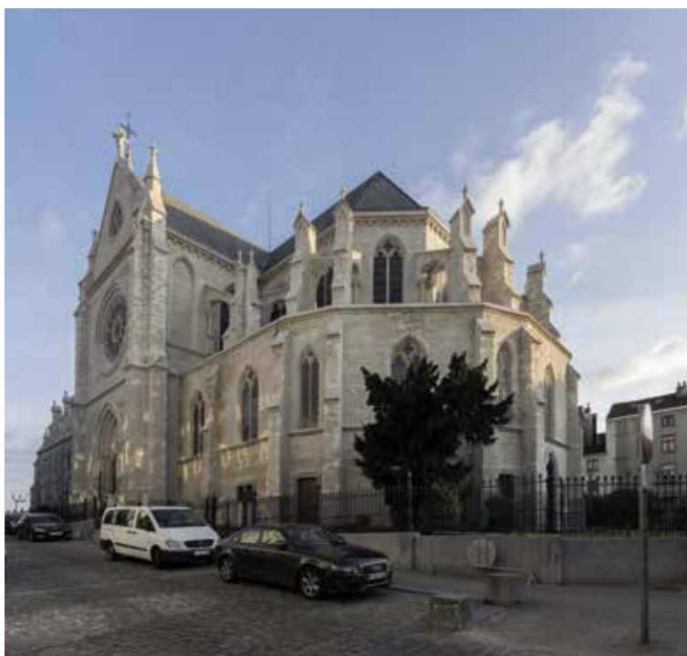
AFB. 11 De noordelijke gevel en het transept na de restauratie, oktober 2019. (© Marie-Françoise Plissart)
