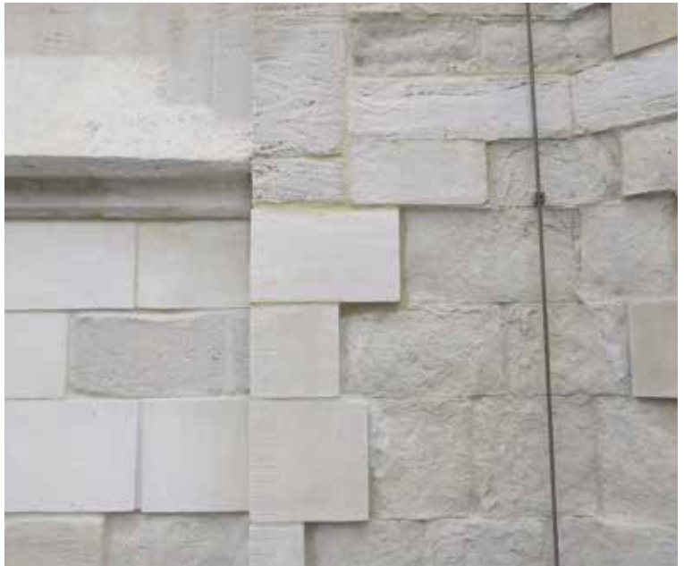
AFB. 9 Parement na reiniging en restauratie. De enkele stenen die werden vervangen kregen de oorspronkelijke geciseleerde afwerking, 2019. (© Ma²)
