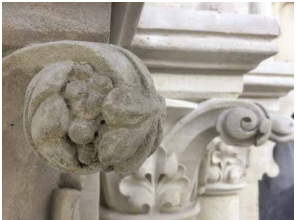
AFB. 10 Reconstructie met restauratiemortel van een voluut op het kapiteel van het portaal van het zuidelijke transept waarvan de decors dreigden te verdwijnen, 2018. (© Ma²)
