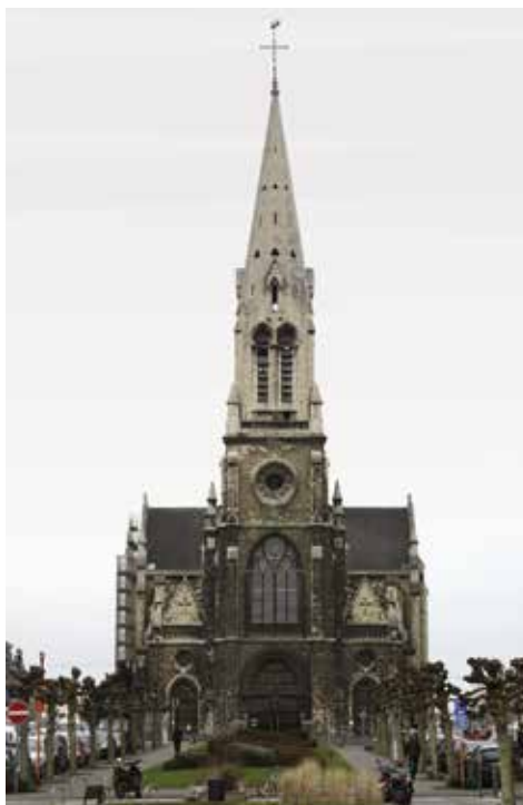
AFB. 1 Hoofdgevel vóór de restauratie gezien vanaf de Louis Bertrandlaan, 2013. (© urban.brussels)
