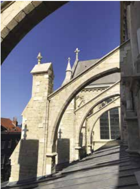
AFB. 8 Luchtbogen na reiniging en restauratie. De lage daken werden vernieuwd en de kruisbloemen gereconstrueerd, 2019. (© Ma²)
